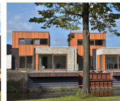
houten gevelbekleding en metselwerk
