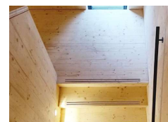
woning opgebouwd uitgelamineerd hout
